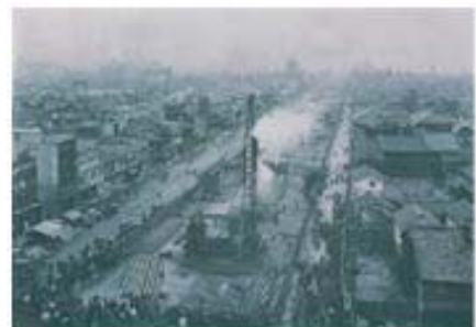
建設中の御堂筋(2) ※国土交通省ホームページより
