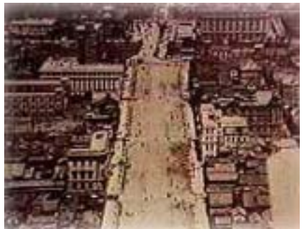
建設中の御堂筋(1) ※国土交通省ホームページより
